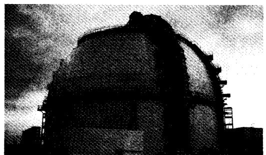
原子炉格納棟
