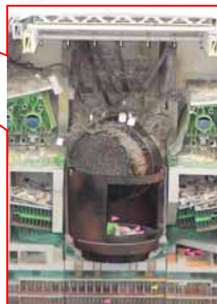
4号炉の破壊した炉心
